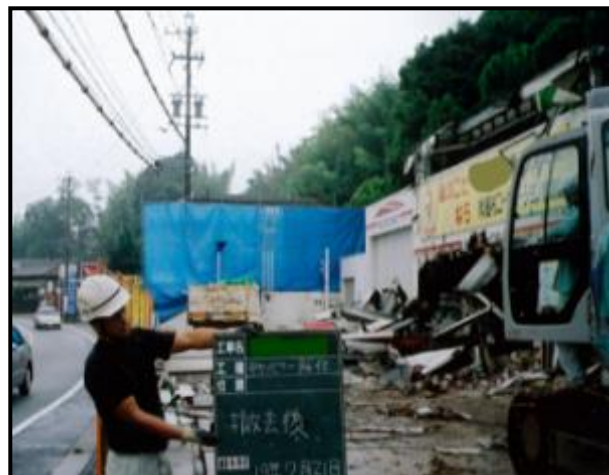
・キャノピー解体(撤去後)
