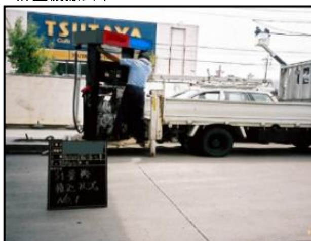
・計量機撤去中
